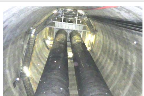
煙突（外筒）の内部を下から見ると
