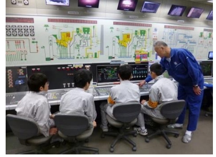
中央制御室の監視業務
