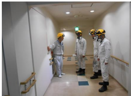
避難通路の点検
