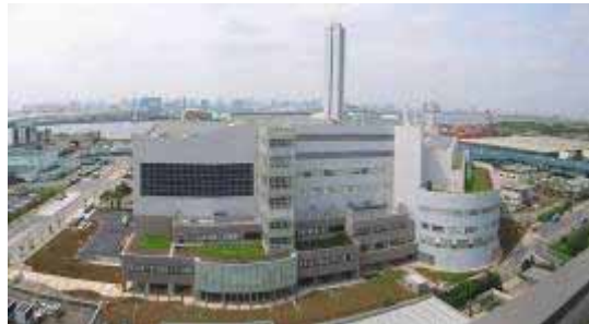
▲南側から見た中防灰溶融施設外観
