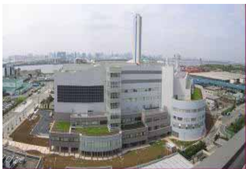
左：中防灰溶融施設の外観
