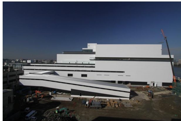
建設中の大田清掃工場（平成25年10月30日現在）
