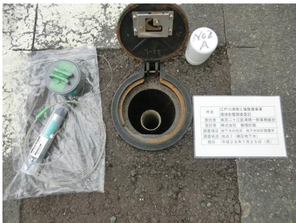
地点② (被圧地下水)
