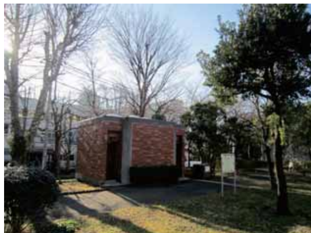
トイレを北側から撮影
