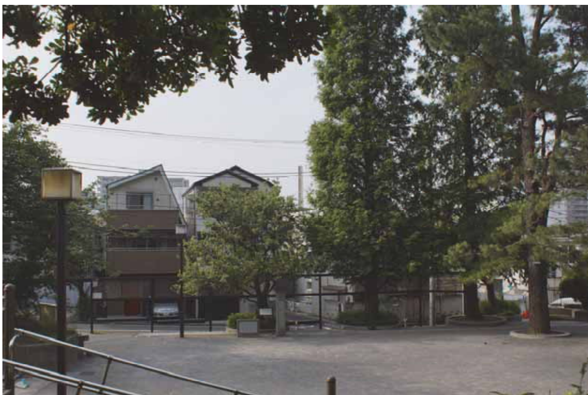
煙突（外筒）は既存煙突と同じ高さとするので、建替え前とほとんど変わらない。 写真 8.9-6 (2) 地点 6 目黒区立不動公園からの景観 (将来)
