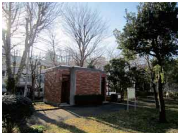
トイレを北側から撮影
