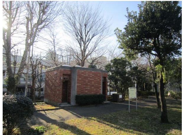
トイレを北側から撮影
