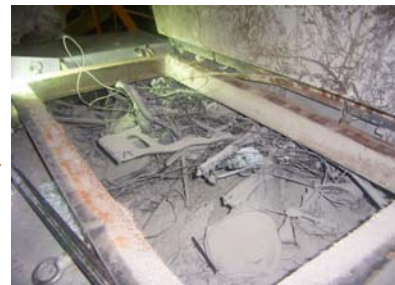
【清掃工場の焼却設備に詰まった金属類】
