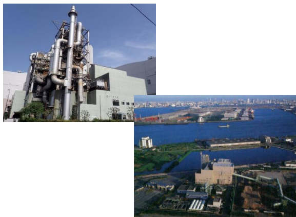
しゅん工当時の破碎ごみ処理施設周辺
