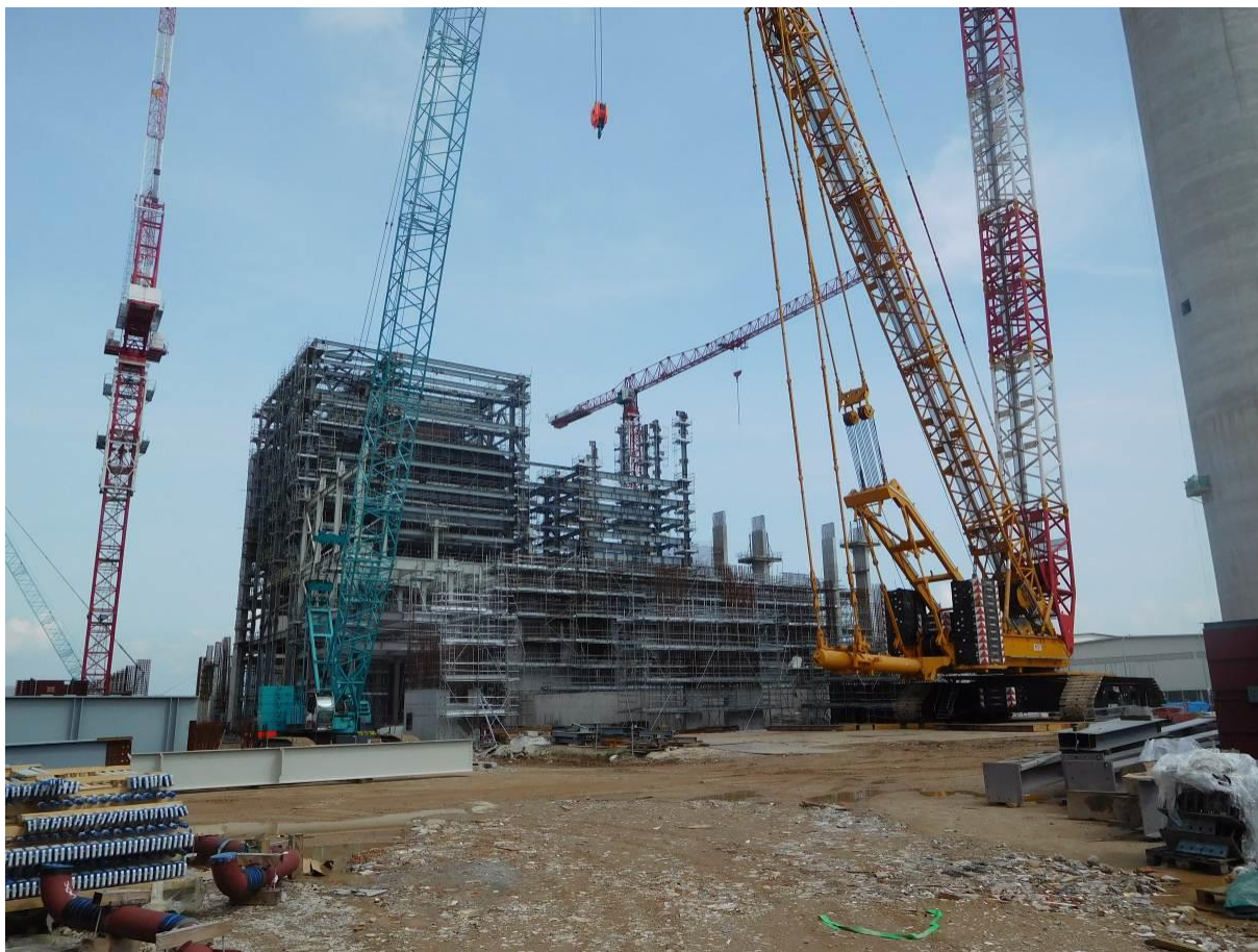
建設中のごみ焼却発電施設
