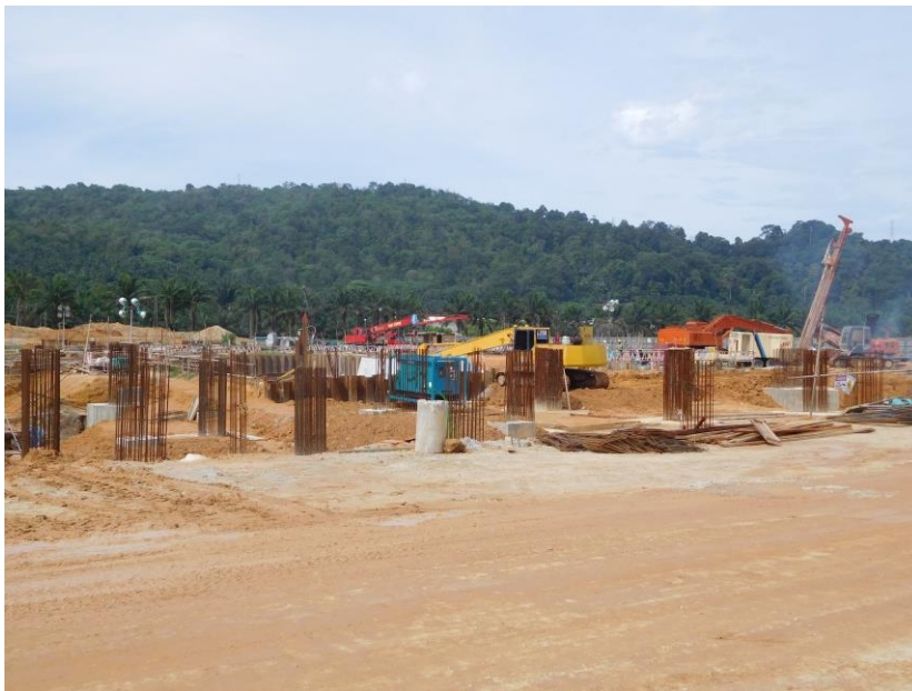
建設中のごみ焼却発電施設
