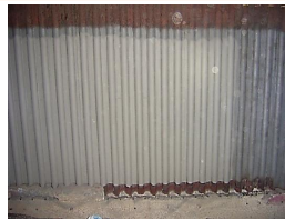
【整備後のボイラ水管】
