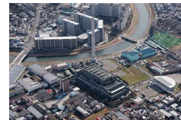
【工場全景写真】
