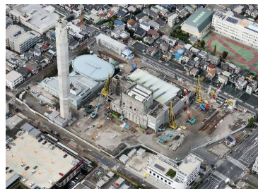
【工事状況写真】(令和6年10月)
