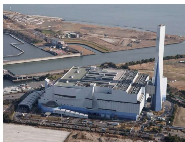
【工場全景写真】
