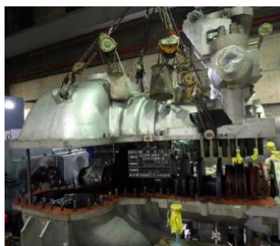
【蒸気タービンの開放点検(発電設備)】
