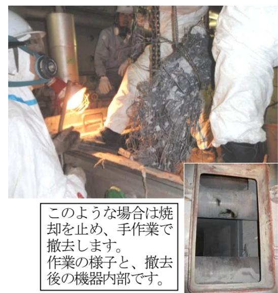
このような場合は焼却を止め、手作業で撤去します。作業の様子と、撤去後の機器内部です。
