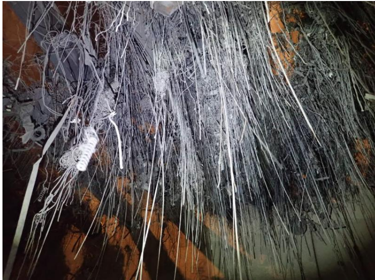
焼却炉の下から見たときの不燃物
