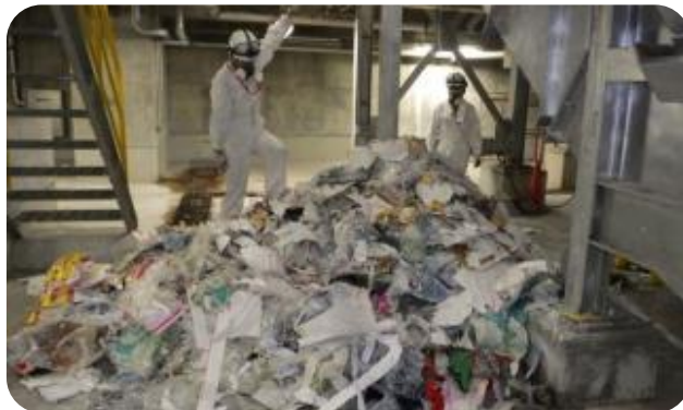
燃えずに機器に詰まった大量の廃プラスチック類 の除去作業の様子(新江東工場)
