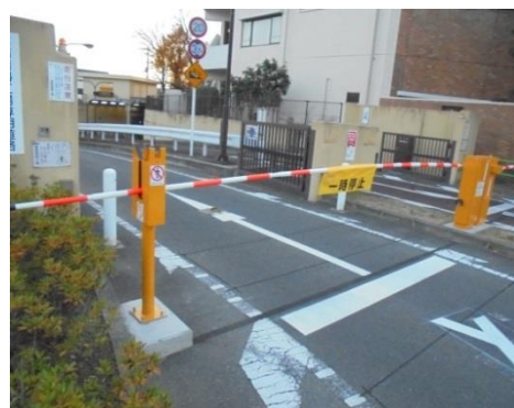
葛飾清掃工場搬入路のゲートバー
