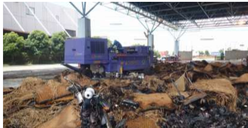
消火後の現場
