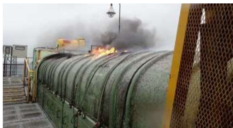
コンベヤ火災
