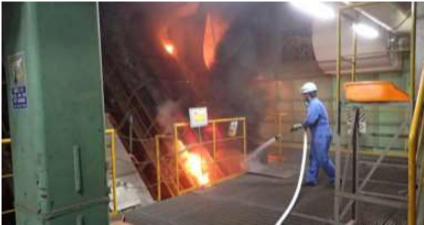
コンベヤ火災
