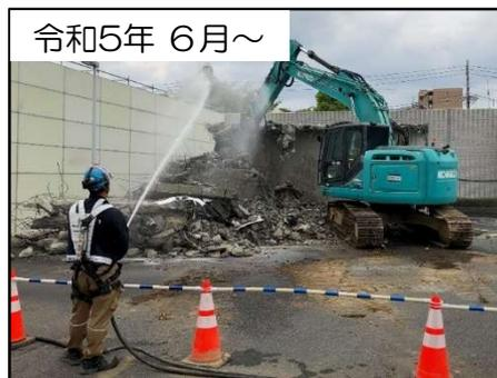
令和5年 6月～ 防音パネルで養生し、発泡性溶液を散布しながら解体しています
