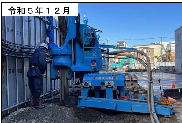
振動対策のために鋼矢板を打設している様子
