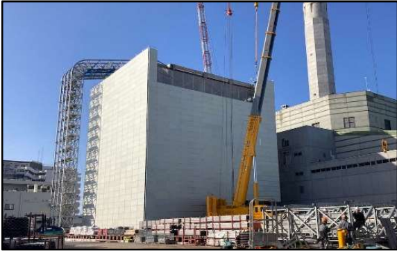
クレーンで仮設テントの骨組を設置している様子
