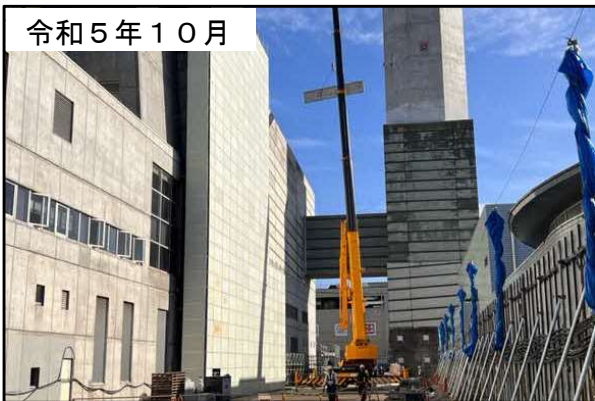
工場棟の外壁をクレーンで取り外している様子
