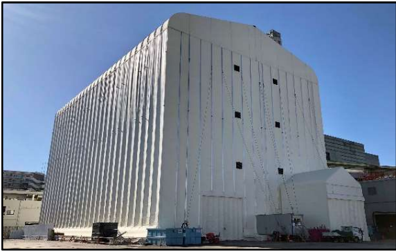
飛灰搬出設備棟を仮設テントで覆った様子
