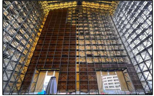
仮設テントの内部に防音パネルを設置している様子
