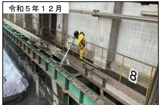
ごみバンカエリアを高圧水で洗浄している様子
