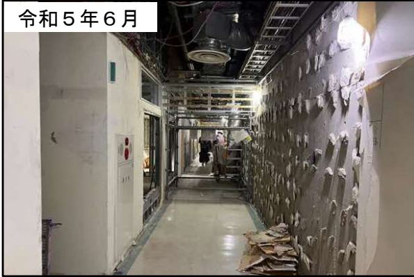
内装材（ボード類）解体後の様子
