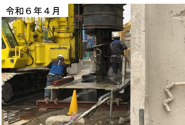
大型杭打機を用いて地中障害物を撤去している様子
