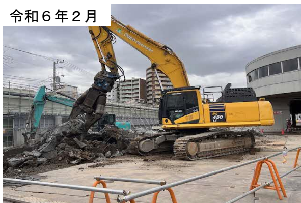
付属棟の基礎を解体している様子
