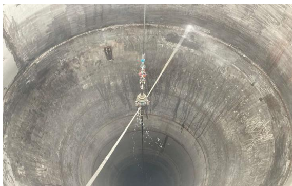
煙突内筒を洗浄している様子
