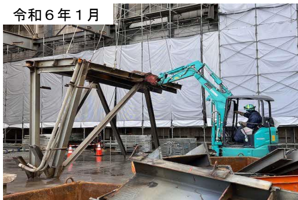
プラント機器を解体している様子
