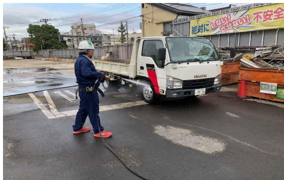
工事車両のタイヤを洗浄している様子
