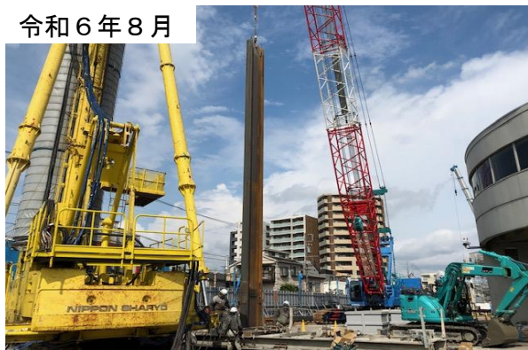
山留壁を造成している様子
