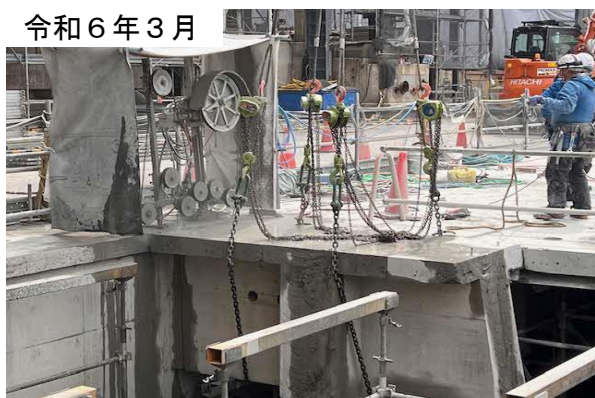
工場棟のコンクリート躯体をワイヤーソー工法で解体している様子
