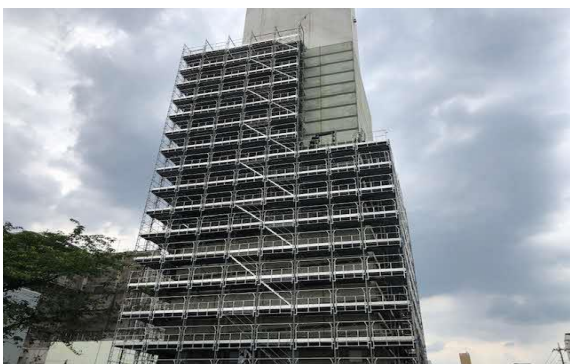
下部のPC板を解体するための足場を組立てている様子
