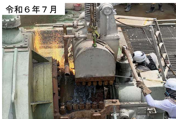
蒸気タービンを解体している様子
