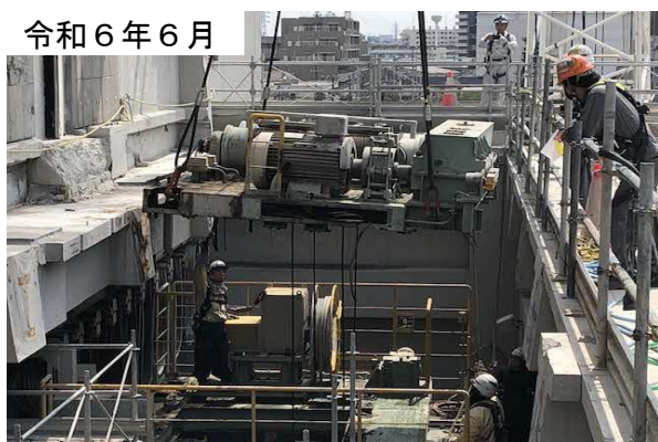
灰クレーンを取り外している様子
