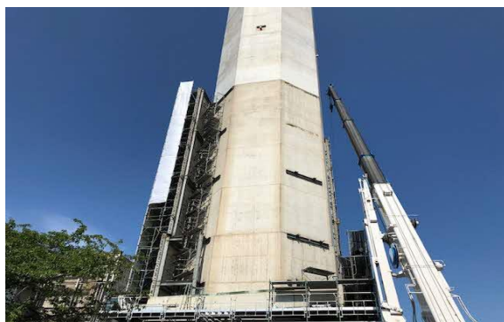
PC板を解体している様子
