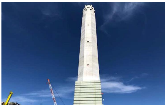
解体作業を始める前の煙突の様子
