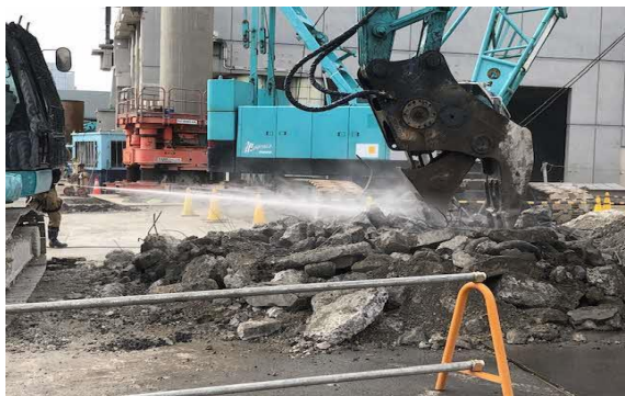
粉じん対策で散水している様子
