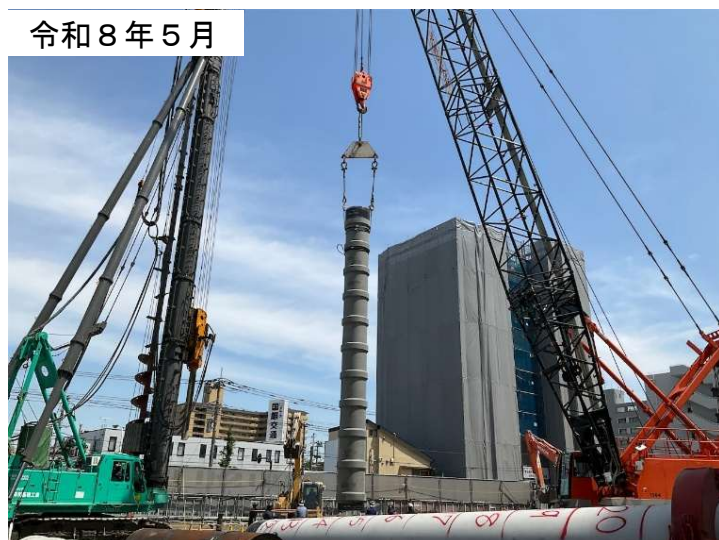
新設建物用の杭工事の様子
