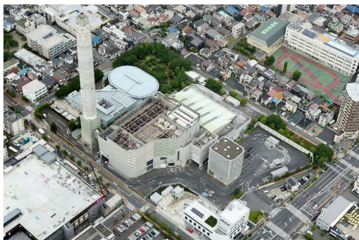
解体工事着手前（令和 5 年）（南東側）
