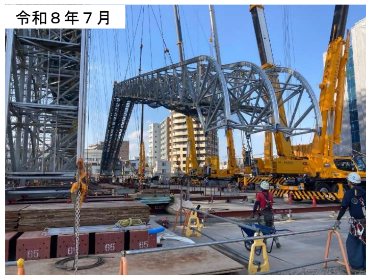
全覆い仮設テントの解体の様子
