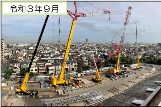
全覆い仮設テントを組み立てるため、重機を設置しています。
