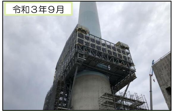
煙突を解体するため、ハットダウンステージの組み立てをしています。
