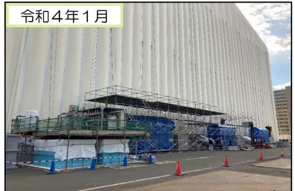
北側に全覆い仮設テント用の負圧集じん機・水処理設備を設置しています。
