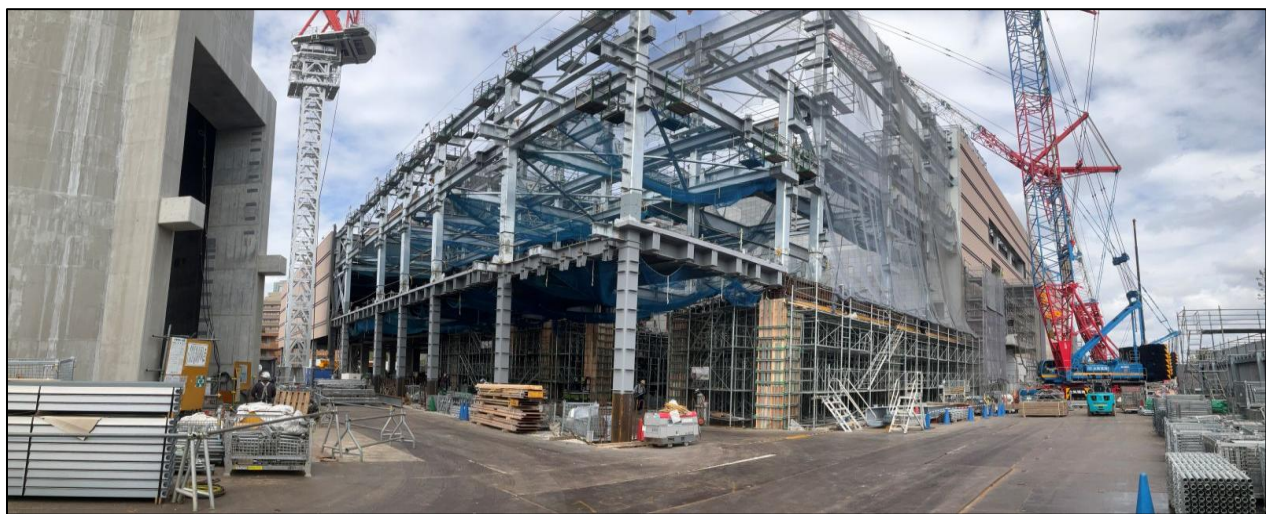
南東側の鉄骨建方の様子
