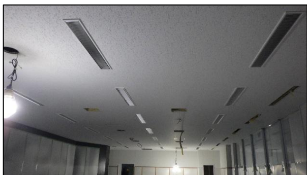
中央制御室の天井仕上げ工事の様子
