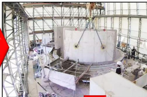
切断した部材は煙突の内部を通して地上へ降ろしています！
