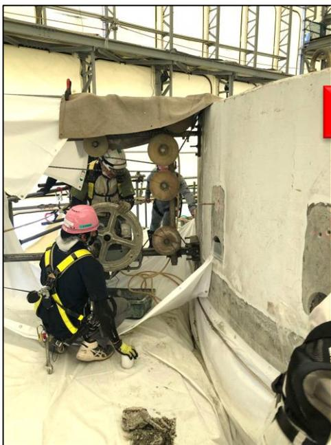
小屋の内部ではワイヤーソーという器具を使って煙突をブロック状に切断しています！
