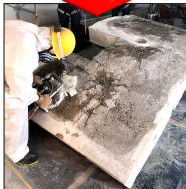
表面の塗装には石綿（アスベスト）が含まれているため、専用の装置で安全に除去してから小割解体していきます。
