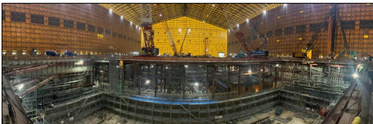
11月 地下2階部分やごみバンクの地下躯体工事を進めています。
