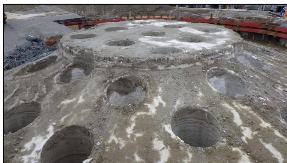
2月 煙突既存基礎の解体着手した直後です。
