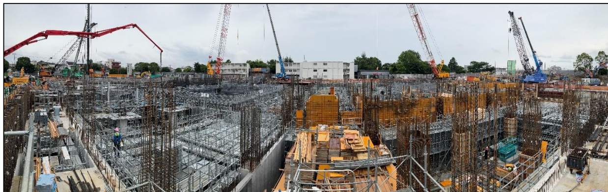
6月 工場棟地下2階躯体はほぼ完成し、地下1階床全てコンクリート打設が完了しました。
