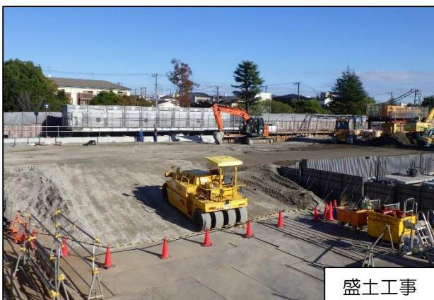
9～1月 東側の擁壁工事と盛土工事の状況です。煙突は基礎杭工事を終え、基礎工事を進めています。
