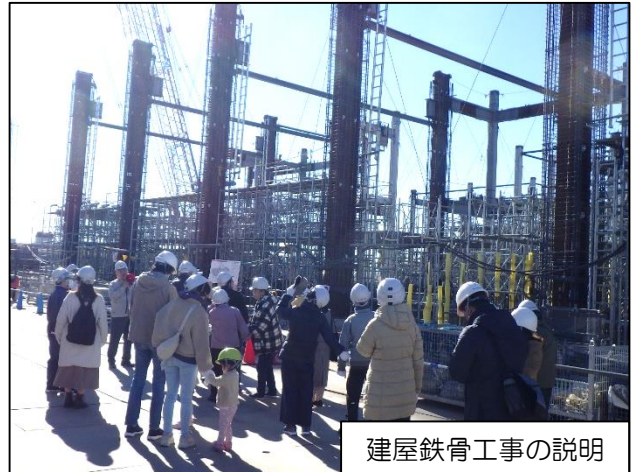
これまでの工事状況の説明
