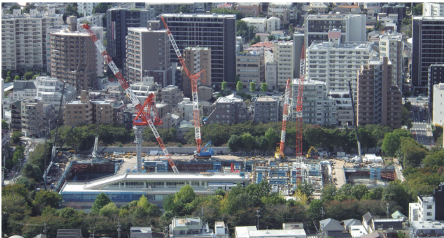
建替工事中の目黒清掃工場（令和 2 年 10 月時点）
