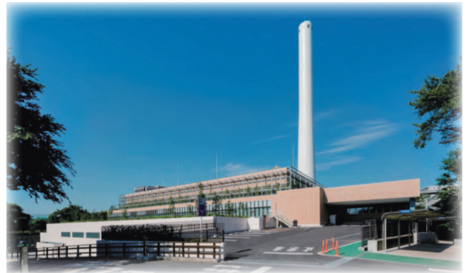
杉並清掃工場（平成29年9月しゅん工）
