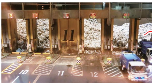
新江東清掃工場 (プラットホームから見たごみバンク)
