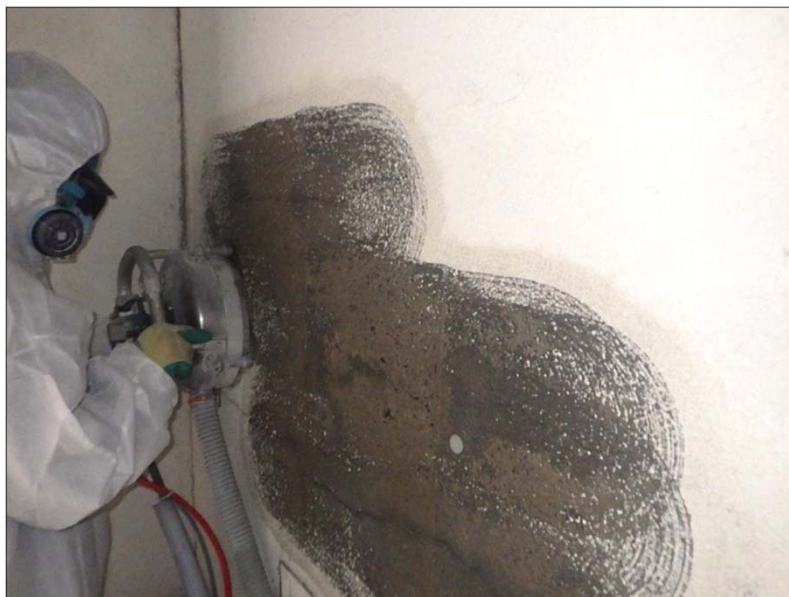
外壁塗材の撤去作業
