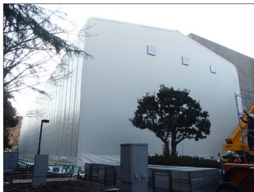
全覆い仮設テントの 設置後
