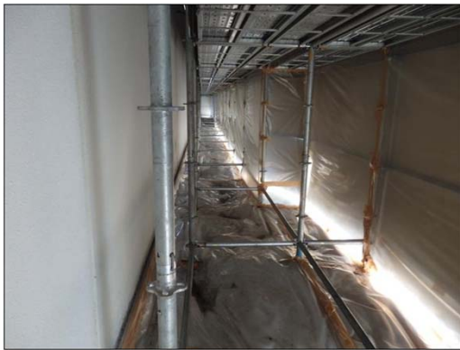
飛散防止の養生
