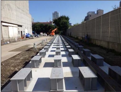
全覆い仮設テントの ベース金物とレールを設置
