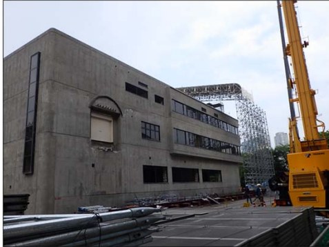
全覆い仮設テントの 組立て中
