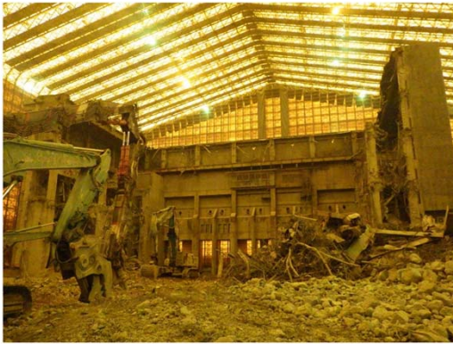
工場棟の解体中 平成31年4月12日
