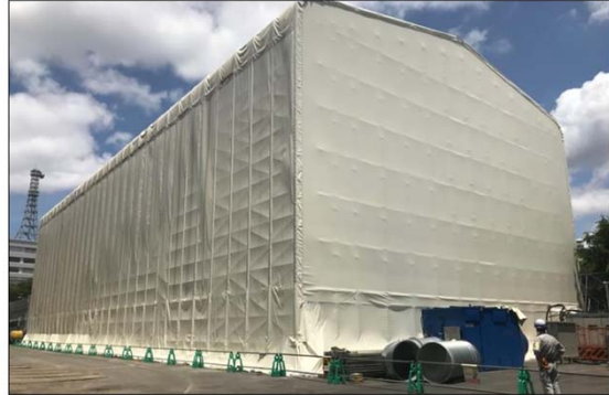
全覆い仮設テントの 設置完了
