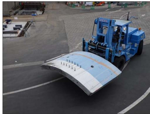
切断した外筒を全覆い 仮設テントへ運搬し解体
