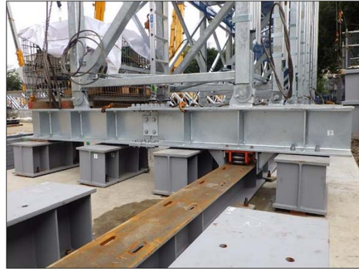
全覆い仮設テントの 壁フレームを設置
