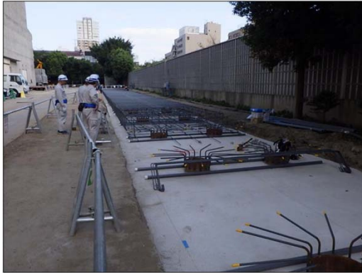
全覆い仮設テント基礎の 杭と配筋
