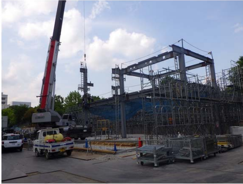
管理棟鉄骨の建設 令和元年5月13日
