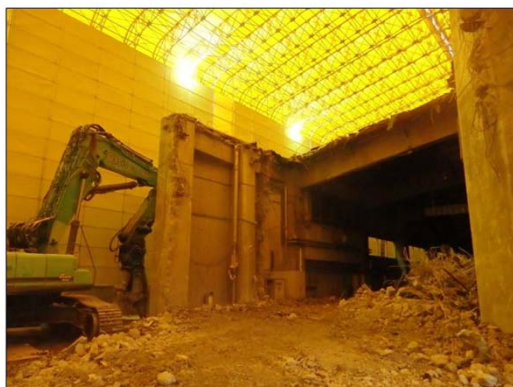
プラットホーム地上部の 解体中
