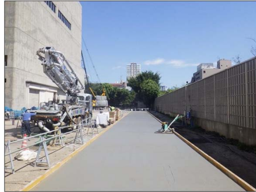
全覆い仮設テント基礎の コンクリート打設
