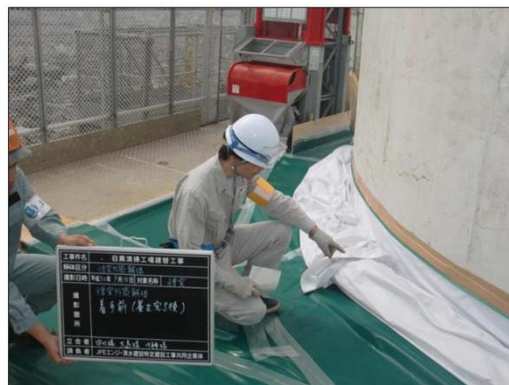
煙突外筒に作業用足場を設置 (足場養生を確認)
