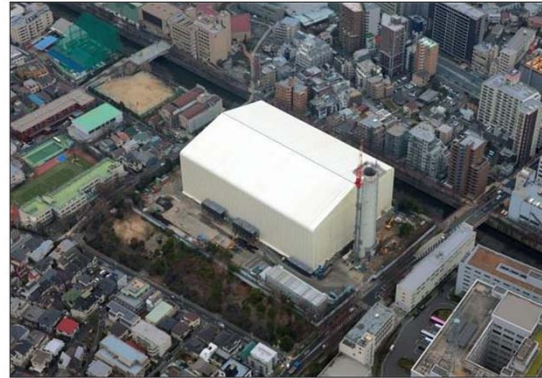
工場全景 平成31年2月中旬
