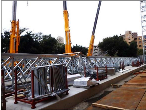
全覆い仮設テントの 屋根フレームを地組み
