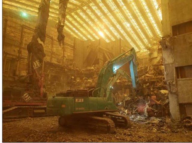
工場棟の解体中 平成31年2月14日
