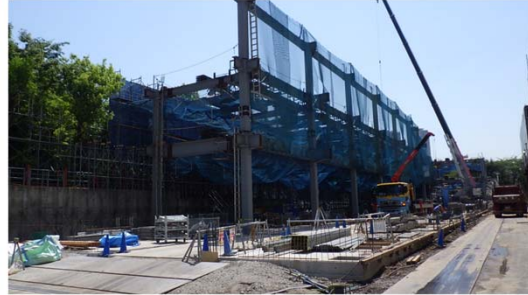
管理棟鉄骨の建設 令和元年5月24日
