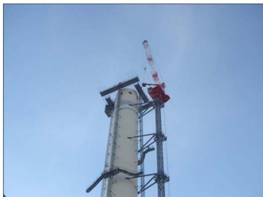
煙突外筒に タワークレーンを設置
