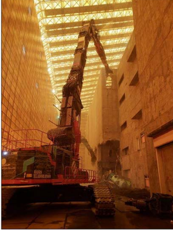
工場棟の解体中 平成31年2月1日
