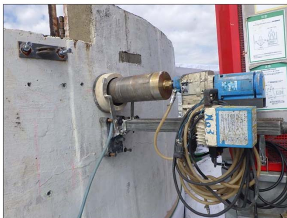
煙突外筒のコア抜き (穴開け)
