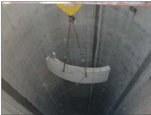
切断した外筒を煙突内部より 吊り下ろす
