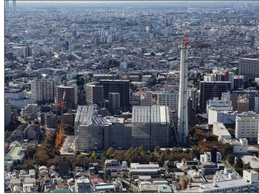
工場全景 平成30年11月中旬
