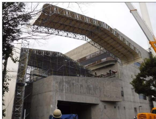
全覆い仮設テントの 屋根フレームを上架
