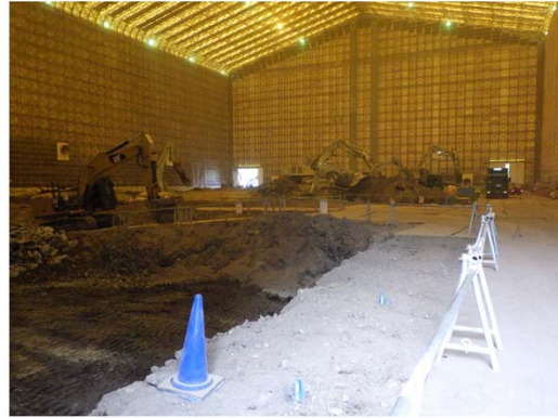
工場棟の解体中 令和元年5月13日
