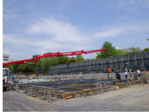
管理棟基礎のコンクリート打設 平成31年4月23日
