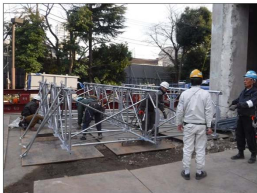
全覆い仮設テントの フレームを地組み
