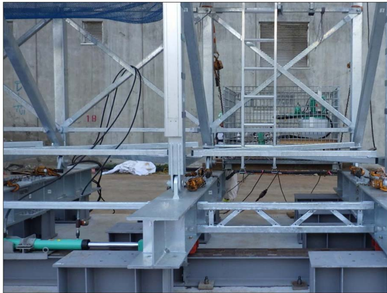
全覆い仮設テントのフレームを移動させる油圧装置
