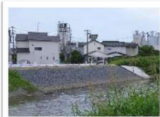
施工事例（A県）
