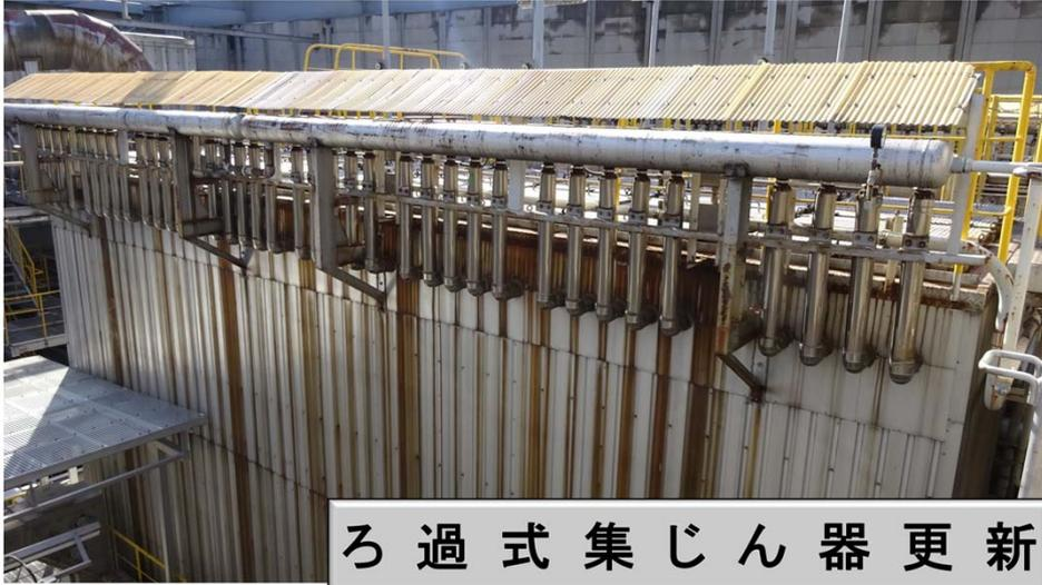
こちらの写真は、有明清掃工場のろ過式集じん器となります。ろ過式集じん器は、バグフィルターと呼ばれるフィルターによって排ガスをろ過することでばいじんを除去する設備となりますが、工場内に設置された機器のなかでも大型の機器となります。この設備の取替えには、400tを持ち上げる能力を持つクレーンを使って設備の更新を行います。
