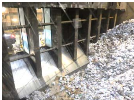
①危機的状況(平成29年11月1日頃撮影) バンク残:約4,000トン 開ゲート: 4/9
