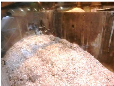
①危機的状況(平成29年11月10日頃撮影) バンク残:約33,000トン ごみ高:約32m
