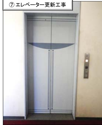
⑦ エレベーター更新工事
