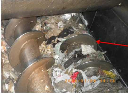
破碎ごみ供給装置スクリー軸に巻き付く破碎ごみ
