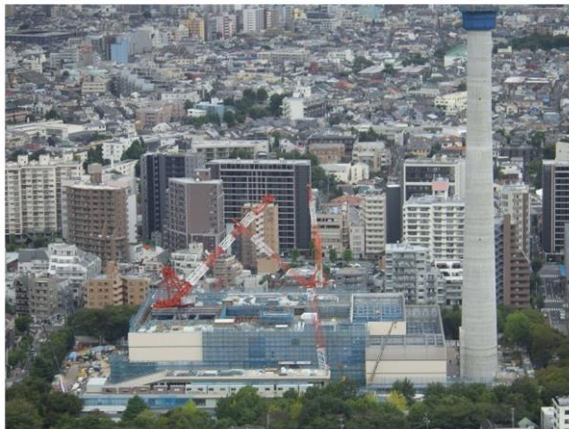
建替工事中の目黒清掃工場
