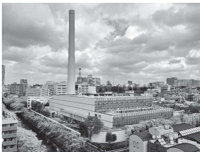
図Ⅲ－8 目黒清掃工場（令和5年3月15日しゅん工）
