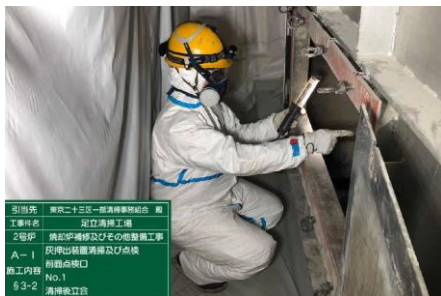
灰搬送装置清掃前の詰まり状況(点検口正面)
