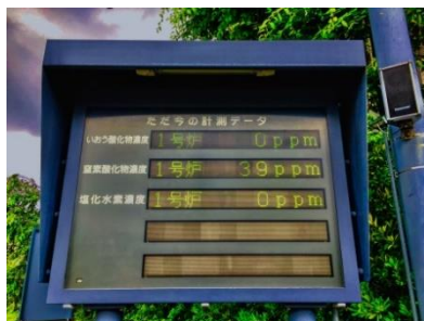
排ガス状況表示盤
