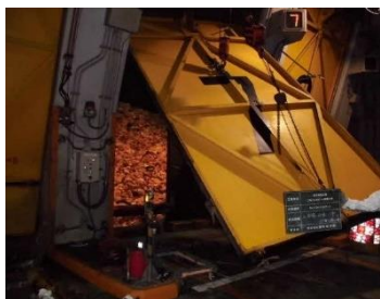
ごみバンカゲート改修工事
