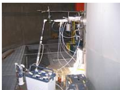
排ガス測定（煙突中段）
