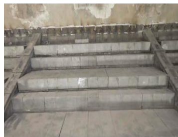
焼却炉火格子工事
