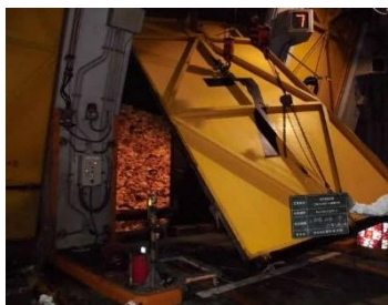
ごみバンカゲート改修工事
