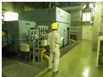
蒸気タービン発電機日常点検
