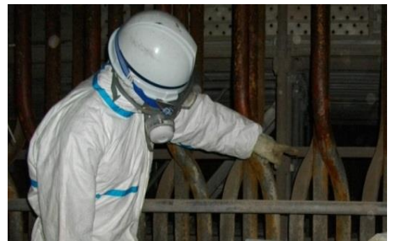
<焼却炉内の点検の様子>
