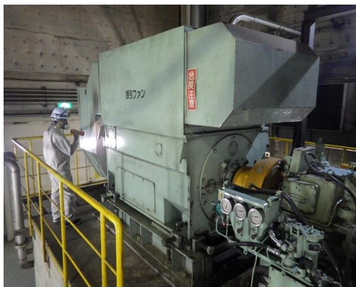
誘引ファン点検作業の様子
