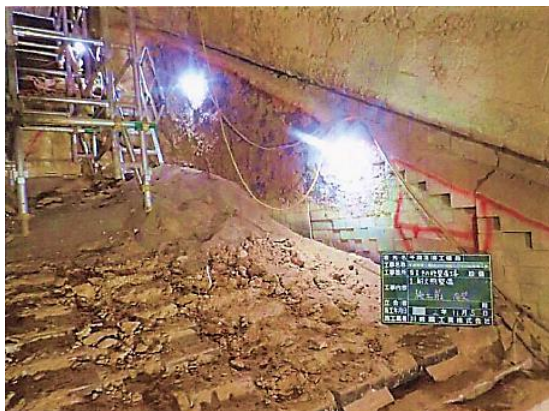
<耐火物補修前>
