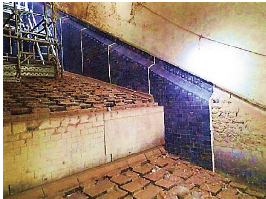
<耐火物補修後>
