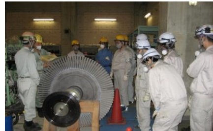
蒸気タービン開放点検の様子
