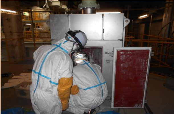
《消石灰貯槽バグフィルターの清掃》
