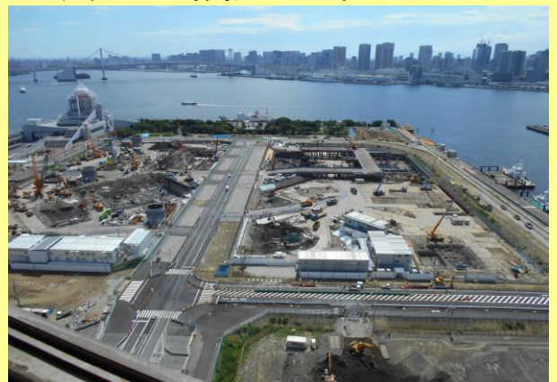
《煙突から見た様子》
