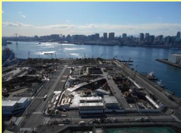
《煙突から見た様子》
